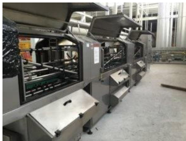
2.1 Сурет-нан пісіру пешін монтаждау
